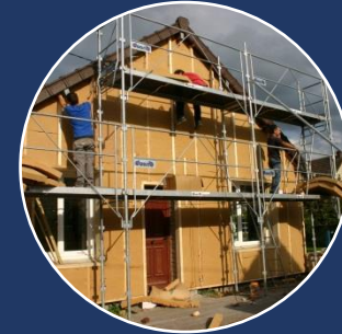
Connaissance et maîtrise de l'énergie
