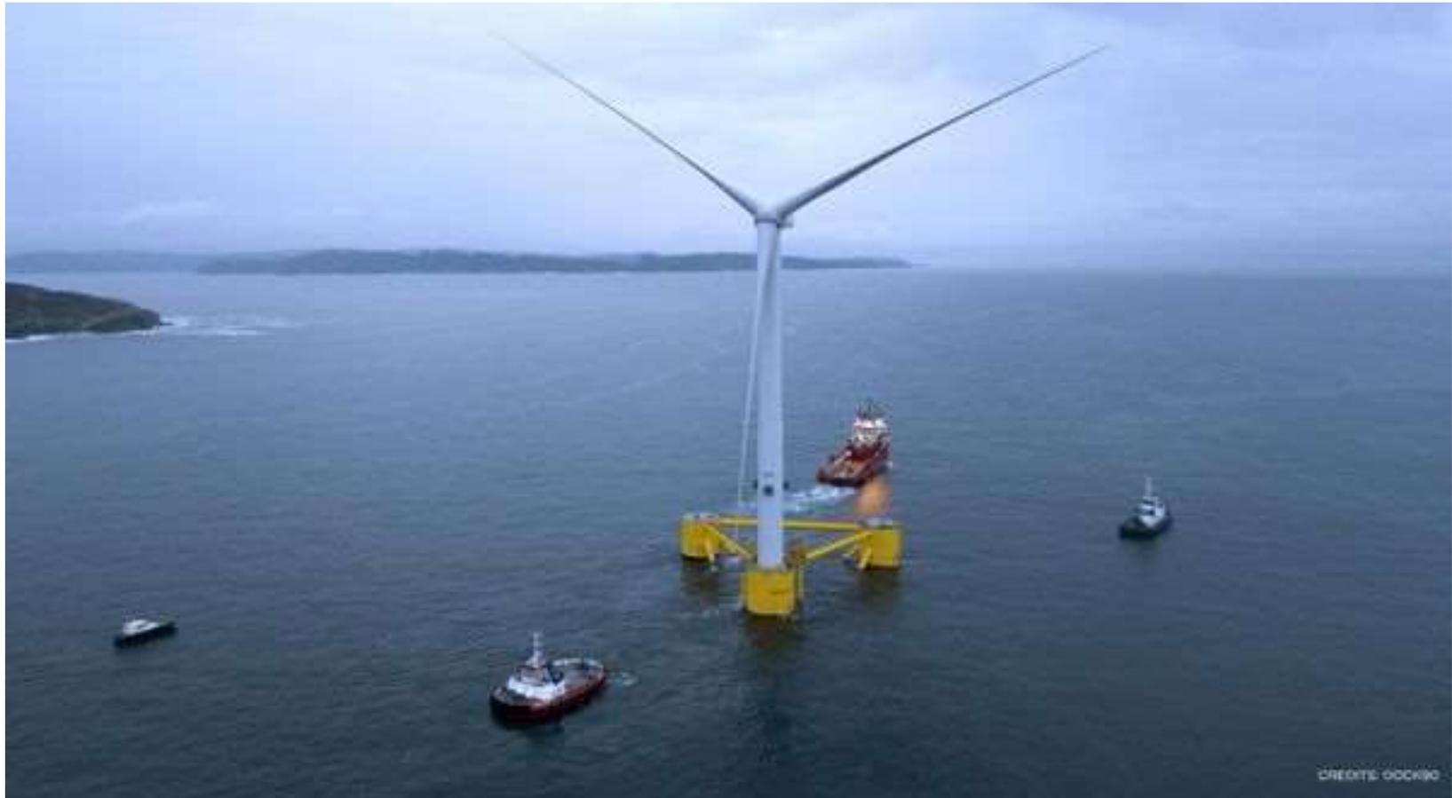
C'est la même machine que pour l'off-shore, mais tractée en place déjà montée. Elle peut donc être réalisée en grande partie dans le chantier naval. Les connexions électriques du flottant, nettement plus compliquées, et les amarrages sont compensés par cette part plus importante réalisée dans des conditions contrôlées d'atelier.
