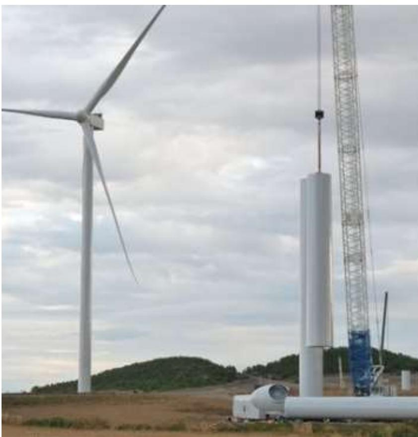
Le parc de Serralta de Cabanillas en Navarre, datait de 1998. Ses 53 turbines [Ecotecnia 300kW] sont remplacées par 9 turbines Nordex pour une augmentation de 30% de sa production.
