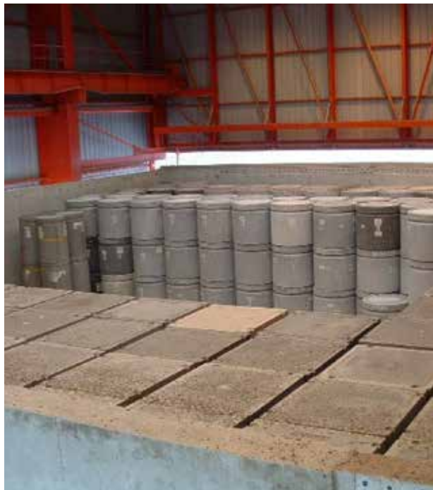
Stockage de colis de déchets dans les ouvrages de stockage du Centre de stockage de l'Aube (CSA)
